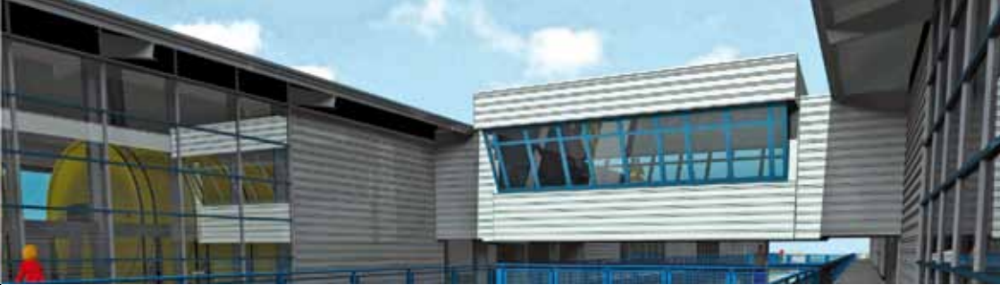
Bedienstand zwischen den östlichen Pylonen
