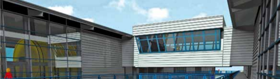
Bedieningstand tussen de oostelijke pylonen
